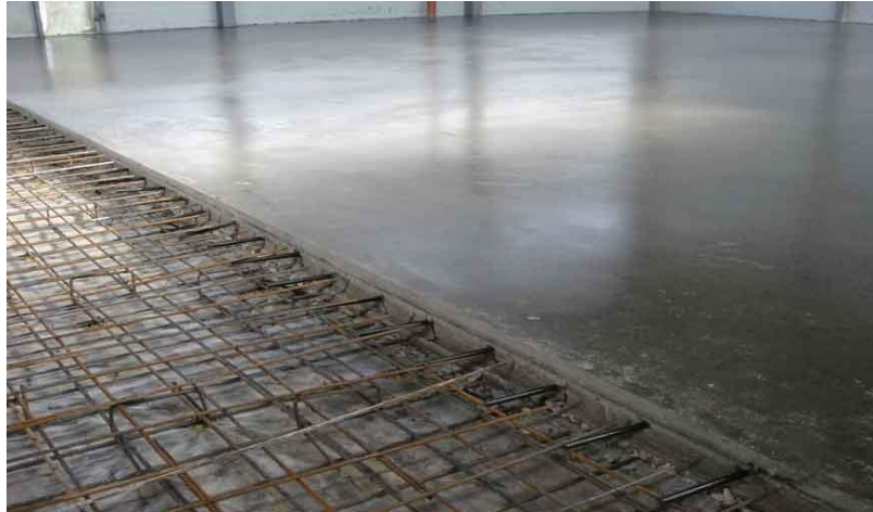
Gbr. 6.11 Konstruksi lantai dengan beton bertulang
